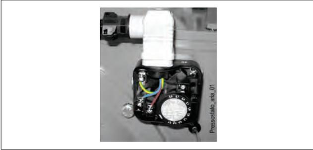
**Gaz basıncının kontrol manostatları** (minimum ve maksimum) gaz basıncı öngörülen değerler içinde olmadığı zaman, brülörün işleyişini engelleme amacına sahiptir.
